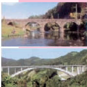
星野川に美しく映える四連橋（上）と今年3月に完成した久留米市と上陽町をつなぐ朧（おぼろ）大橋
