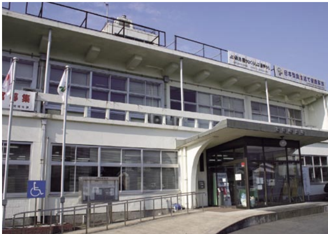
▲久留米市北野総合支所
